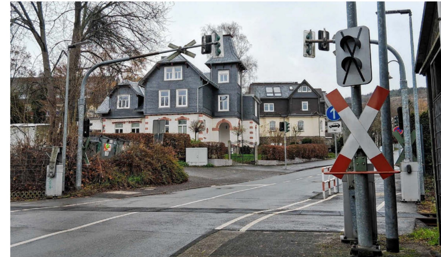
Der Bahnübergang an der Bismarckstraße in Bad Berleburg: Auch hier wurden die Schranken abgebaut.
