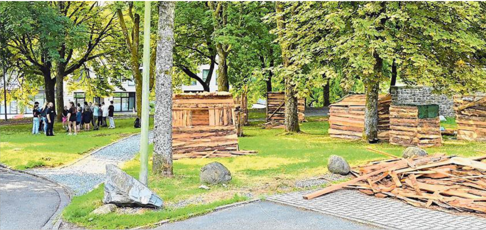
Teamarbeit ist Trumpf: In kleinen Gruppen entstanden unter fachkundiger Anleitung beim Baulager in Erndtebrück sieben individuelle Holzhütten. Fotos: Zukunftsstiftung „Unser Erndtebrück“
